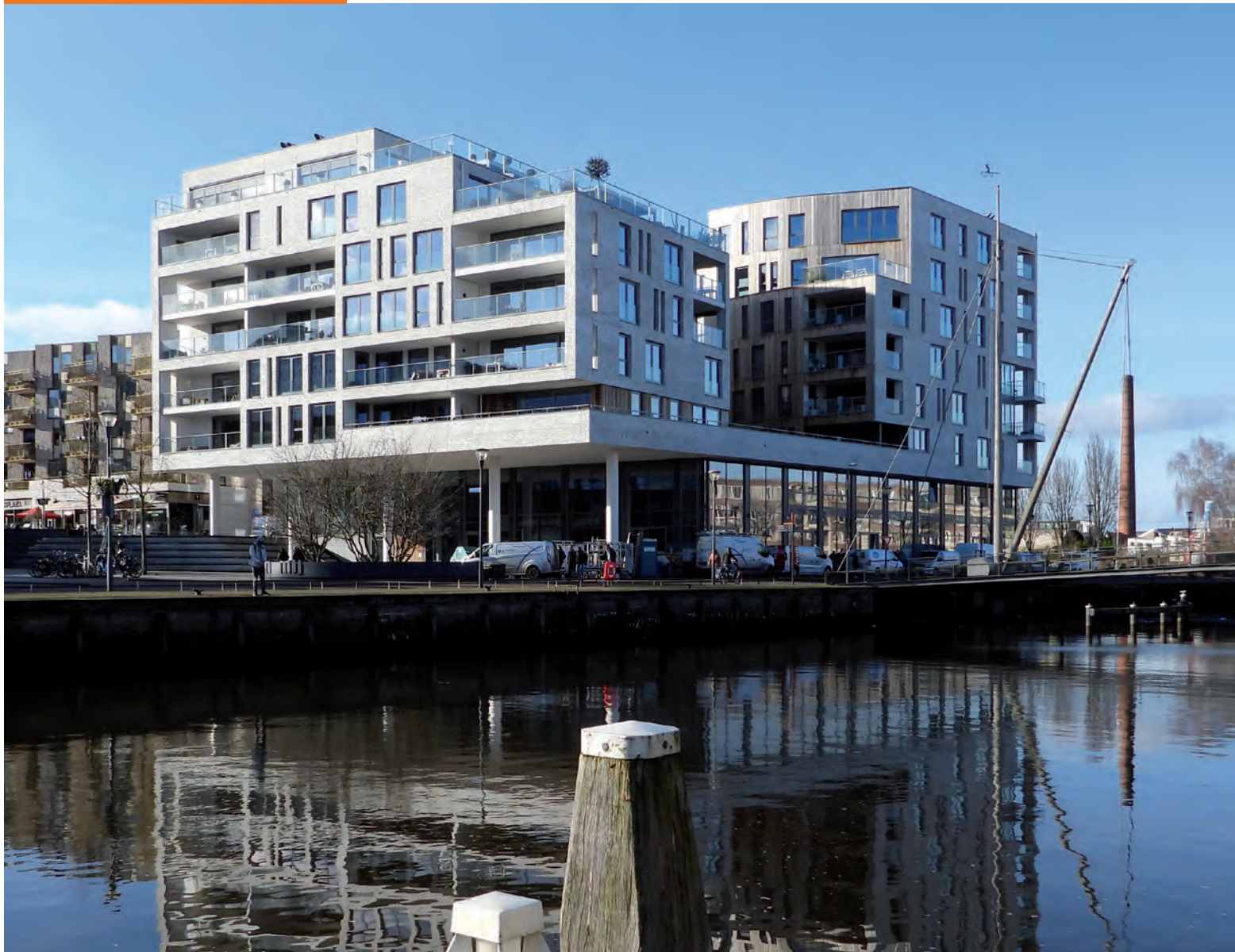
WOONCOMPLEX EEMERALD, EEMPLEIN, AMERSFOORT
