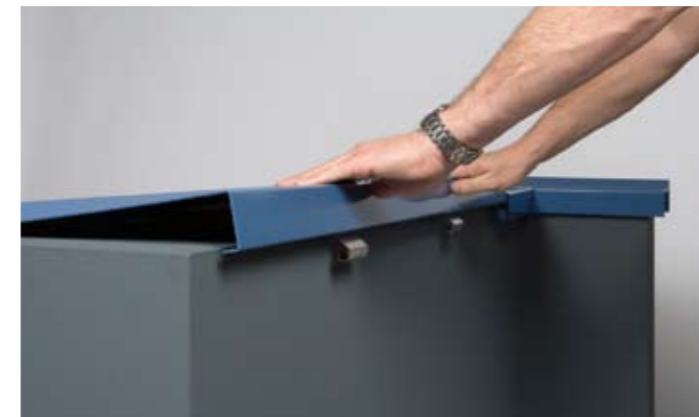
DE MUURAFDEKKAP WORDT OVER DE RVS-VEER GEDRUKT.
