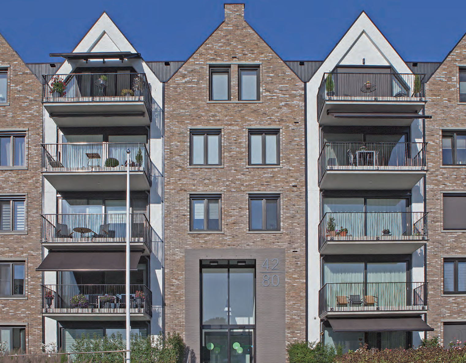
WONINGEN EN APPARTEMENTENCOMPLEXEN VERBORGEN TUINEN, LEUSDEN
